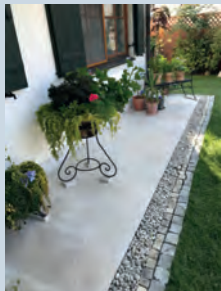
selbstverlegt - mit exakt 2° Gefälle
